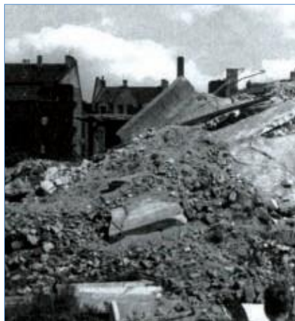
Die Kirche liegt in Trümmern
