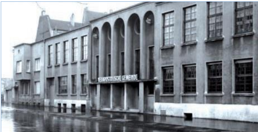
Braunschweiger Straße: die neu errichteten Gebäude
