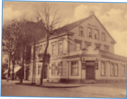
Außenansicht der Gaststätte "Zu der Postkutsche" an der Schürferstraße
