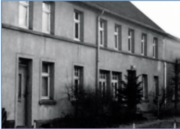
Wegen Baufälligkeit musste der seit 1928 genutzte Kirchensaal als Versammlungsstätte für die Gemeinde 1971 aufgegeben werden, eine Außenansicht gibt es nur von dem vorgelagerten Wohnhaus
